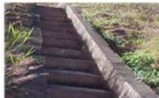
Descida d'água em degraus
