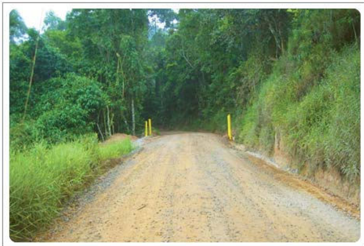
Foto mostrando leito da estrada após a compactação
