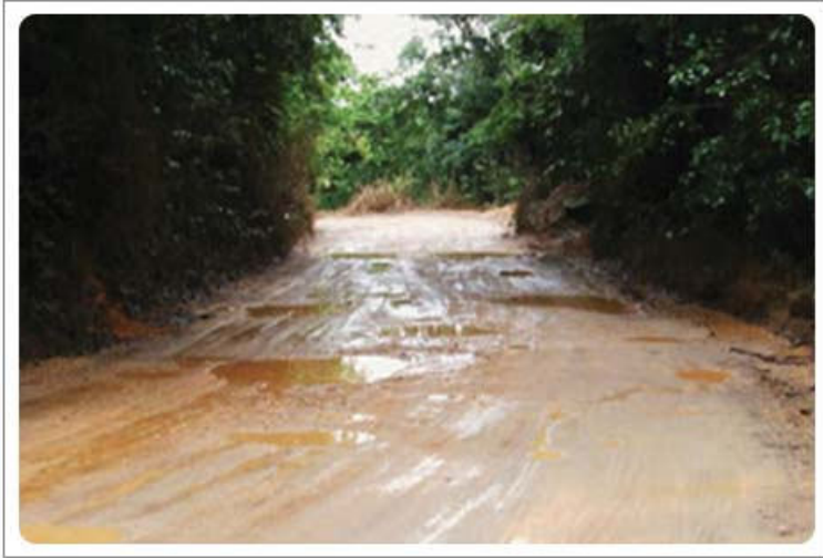
Foto mostrando pista de rolamento danificada por problemas de drenagem
