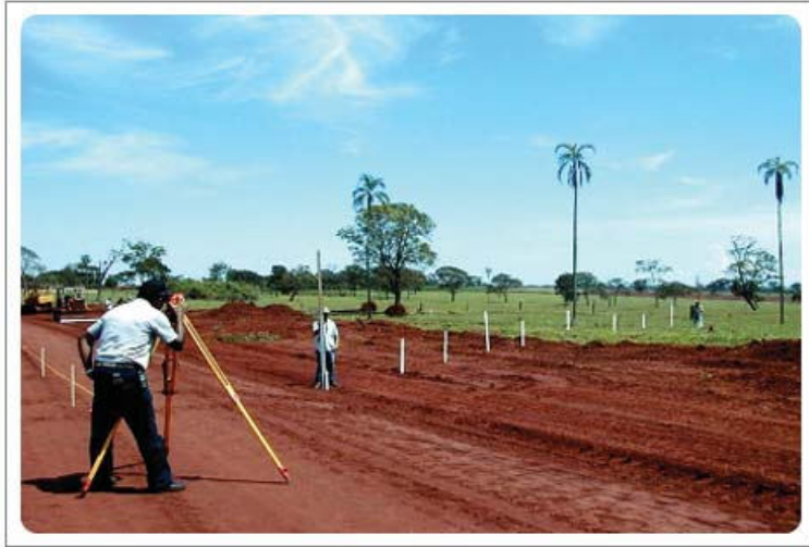
Transporte da cota da estaca localizada no canal de drenagem lateral, para a última estaca do terraço.
