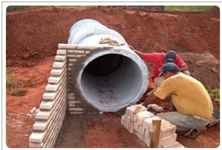
Foto mostrando a etapa de instalação de tubulação de fluxo transversal
