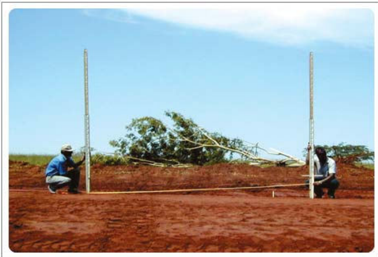
Detalhamento de locação de lombada
