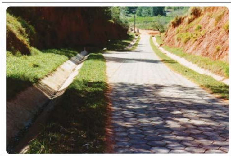
Foto mostrando sistema de drenagem com canaleta de concreto armado.
