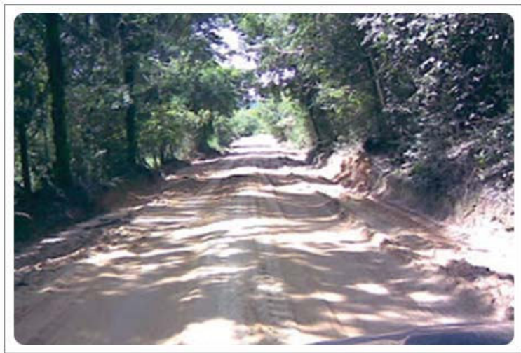
Foto mostrando situação de má capacidade de suporte da pista de rolamento e o surgimento de trilhas.
