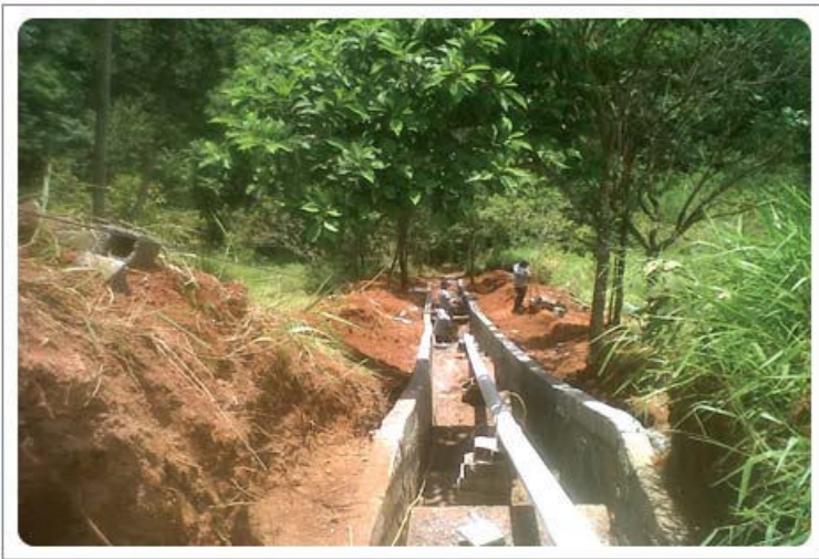
Foto mostrando construção de escada hidráulica
