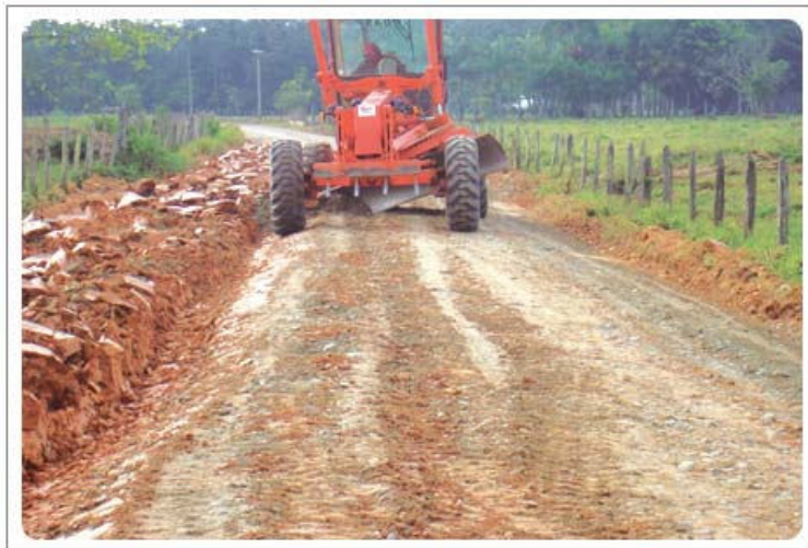
A foto mostra execução de reforço de subleito por defeitos na plataforma da estrada.
