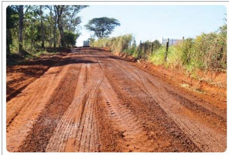
Foto mostra a aplicação do revestimento primário
