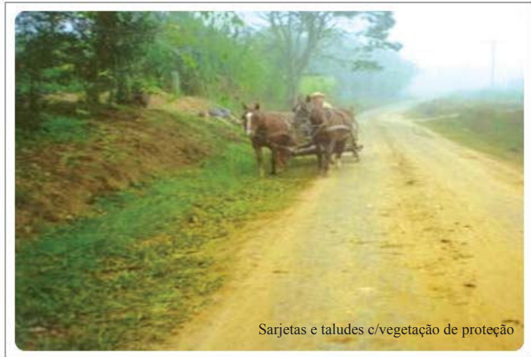
Foto mostrando sarjeta com plantio de vegetação.
