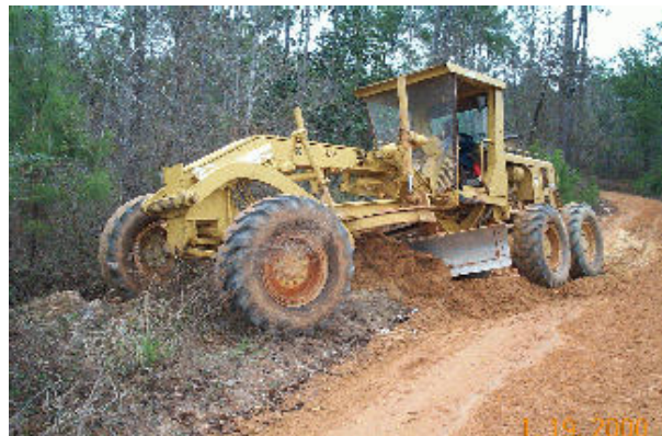
Figura 27: a motoniveladora criando novo bigode na estrada (Fonte: Ken Skorseth, 2000)
