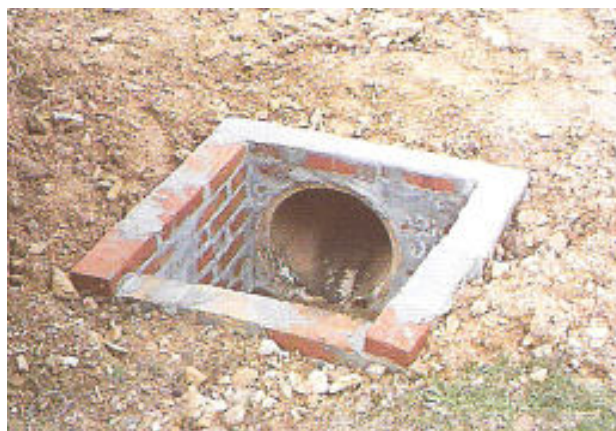
Figura 33: caixa coletora feita com tijolos, argamassa e os tubos são de concreto
