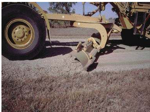
Figura 55: motoniveladora fazendo espalhamento dos materiais (Fonte: Ken Skorseth, 2000)
