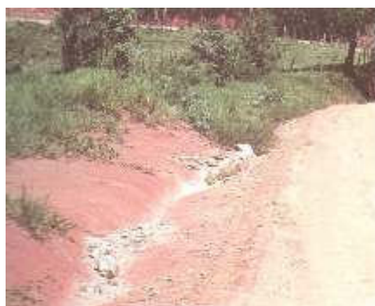
Figura 31: pedras ao longo da sarjeta agindo como dissipadores de energia (Fonte: Ken Skorseth, 2000)
