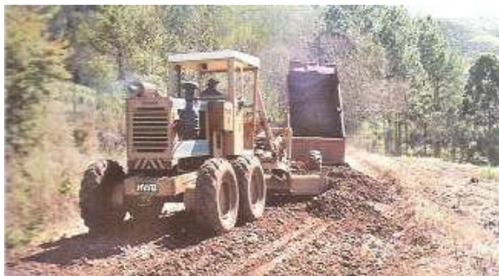
Figura 38: caminhão basculante despejando material para revestimento e a motoniveladora espalhando (Fonte: Baesso e Gonçalves, 2003)
