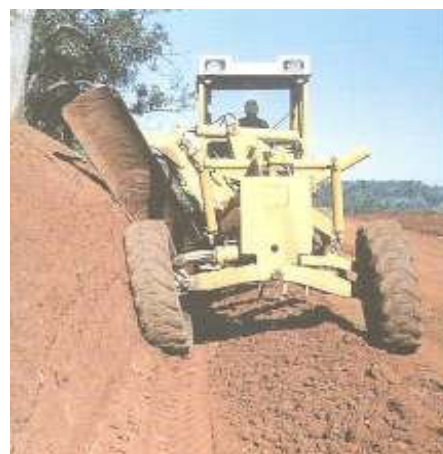
Figura 59: motoniveladora reconformando talude (Fonte: Ken Skorseth, 2000)
