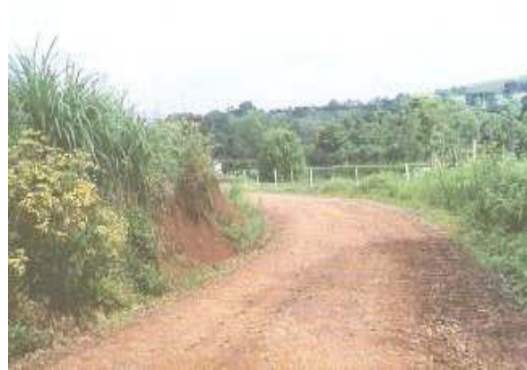
Figura 43: estrada bem compactada (Fonte: Ken Skorseth, 2000)
