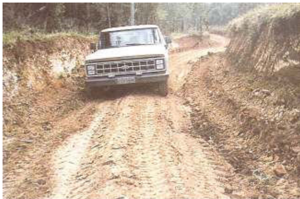
Figura 3: seção transversal imprópria (Fonte: Baesso e Gonçalves, 2003)
