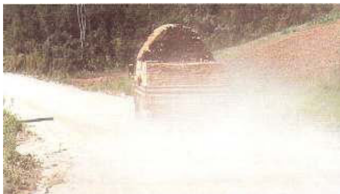
Figura 6: Excesso de Poeira (Fonte: Baesso e Gonçalves, 2003)
