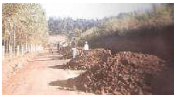
Figura 37: pilhas de basalto alterado para ser utilizado como camada de revestimento. (Fonte: Baesso e Gonçalves, 2003)
