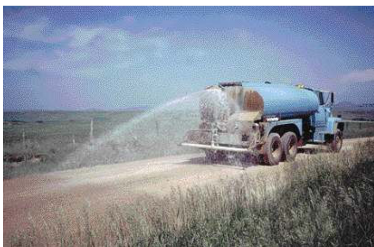
Figura 39: caminhão tanque umedecendo a mistura (Fonte: Ken Skorseth, 2000)
