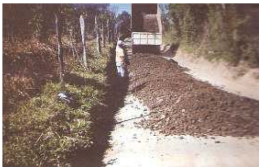
Figura 35: caminhão basculante despejando material ao longo do trajeto (Fonte: Baesso e Gonçalves, 2003)
