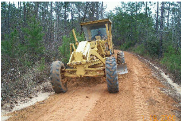
Figura 26: motoniveladoras podem criar e fazer a manutenção dos bigodes de forma bastante simples (Fonte: Ken Skorseth, 2000)
