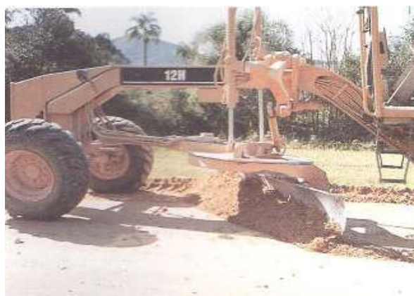
Figura 53: motoniveladora fazendo a mistura dos materiais (Fonte: Joe K. Parker, 2000)
