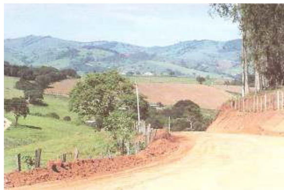
Figura 29: leira muito bem executada. A leira proporciona proteção ao bordo da pista e ao corpo de aterro como um todo. Na ausência dela, teríamos um processo erosivo neste trecho (Fonte: Ken Skorseth, 2000)
