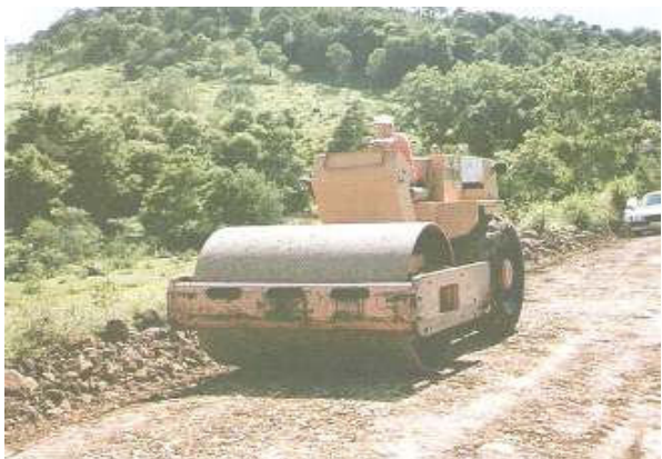
Figura 42: Rolo compactador atuando no revestimento (Fonte: Baesso e Gonçalves, 2003)
