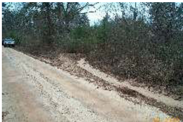
Figura 25: bigodes ajudam a manter a estabilidade do volume e velocidade da água nas sarjetas (Fonte: Ken Skorseth, 2000)
